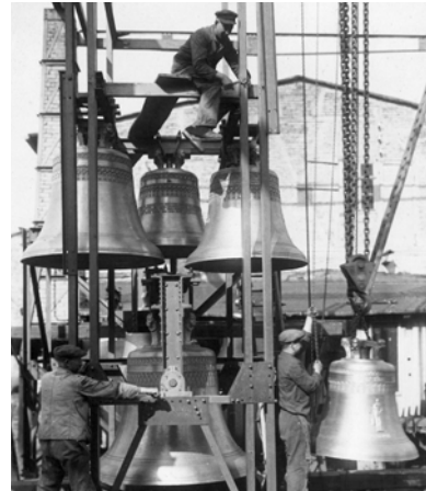
Montageplatz der Glockengießerei Franz Schilling Söhne
