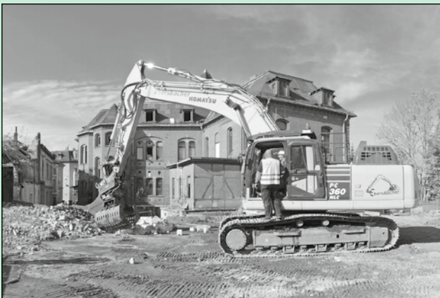
Es erfolgte der offizielle Baubeginn zur Entwicklung des ehemaligen RST-Geländes durch die LEG Thüringen. Auf der 2,2 Hektar großen Fläche sollen insgesamt 22 Parzellen zur Eigenheim-Bebauung entstehen.
