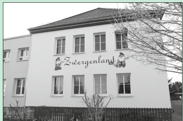
In der Kindertageseinrichtung „Zwergenland“ wurde die energetische Sanierung des Gebäudes abgeschlossen. Die Kosten dafür betragen rund 360.000 Euro.
