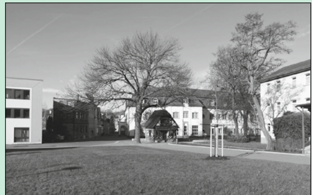
Nach 15 Monaten Bauzeit wurde die Großbaustelle „Umgestaltung Darrplatz/Melanchthonplatz/Knoten Dornburger Straße/Bernhardstraße“ beendet.
