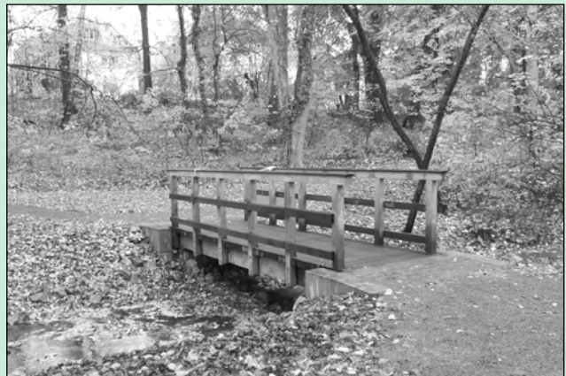
In der Schötener Promenade wurden 8 Brücken nach umfangreichen Sanierungsmaßnahmen im Rahmen des Hochwasserschutzprogramms wieder freigegeben.
