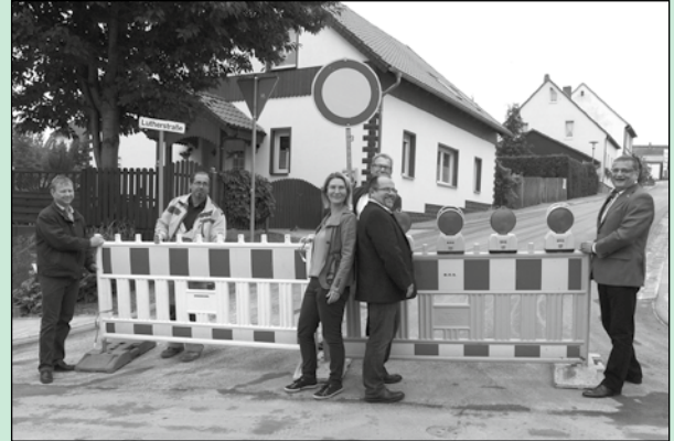
Im Ortsteil Oberroßla erfolgten nach umfassendem Ausbau die erwartete Freigabe der Straßen „Lutherstraße“ und „Neuer Weg“.
