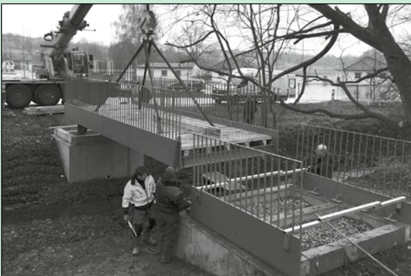
Im Rahmen des Hochwasserschutzprogramms wurden drei Brücken über den Herressener Bach in der Promenade neu errichtet.
