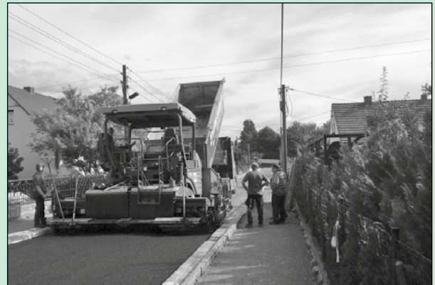
Nach grundhafter Sanierung und umfangreichen Ausbaurbeiten wurde der erste Bauabschnitt in der Schieringstraße wieder freigegeben.
