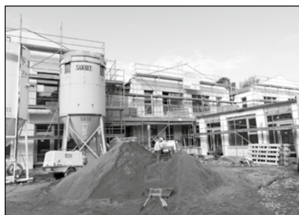
Neubau Kindertageseinrichtung August-Bebel-Straße 18a
