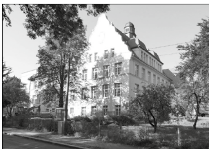
Sanierung und Umbau Staatliche Grundschule „Am Schötener Grund“
